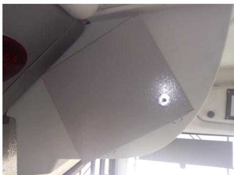
Figura 3 - Externa, mas dentro de um Box de Proteção com Fechadura
